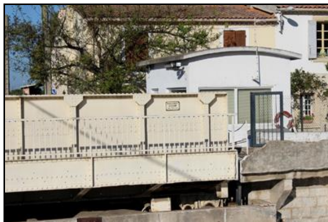
VUE SUPERIEURE ET TABLIER
