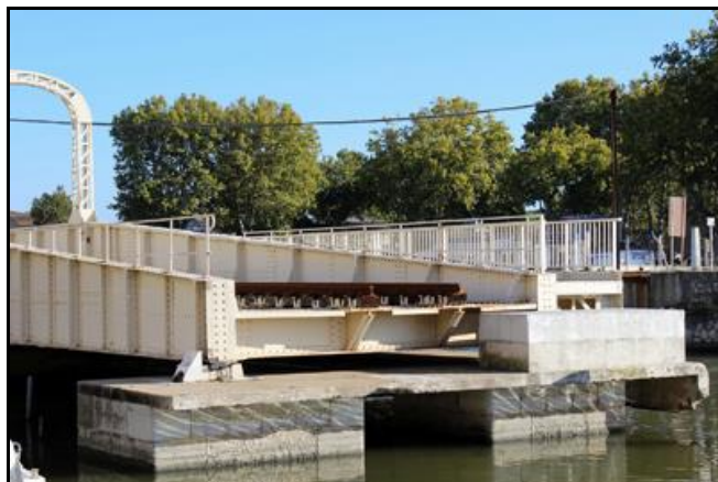
Ci-dessus et ci-après, les deux extrémités du tablier, avec la guérite qui permet de commander la rotation
