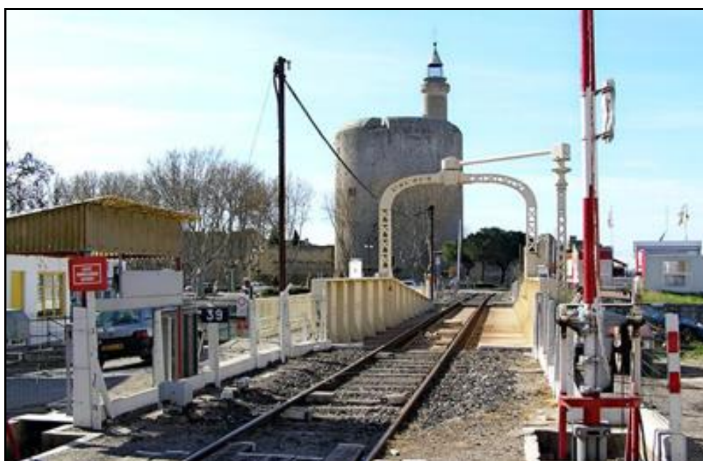
Le tablier du pont fermé vu dans le sens de la ligne
